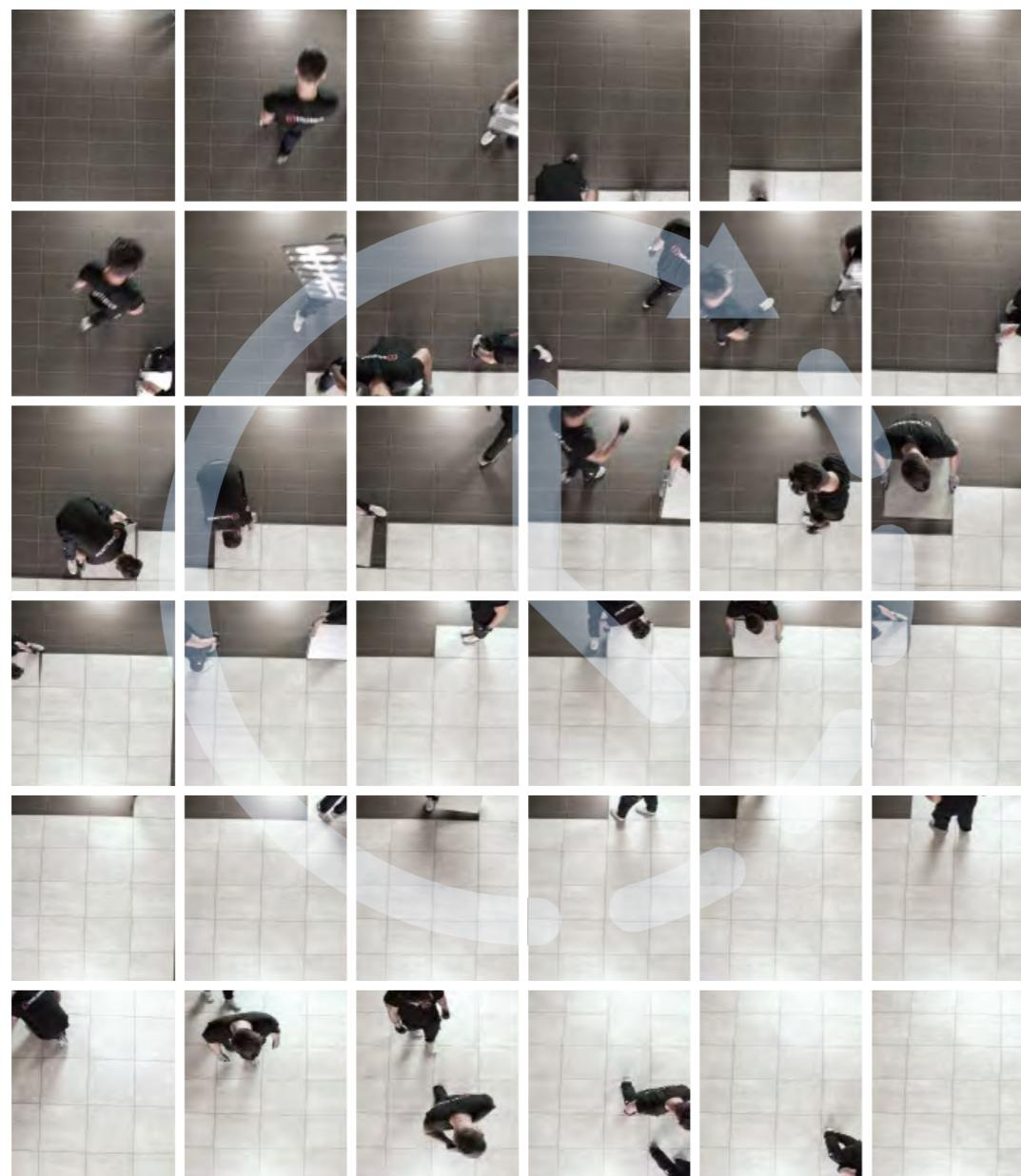
Il sistema di posa a incastro con un clic Pave and Go, concepito appositamente per pavimentazioni in ceramica per interni, permette di posare le piastrelle facilmente e velocemente su massetti o su vecchie pavimentazioni. Occorre soltanto allinearle e incastrarle con un clic per ottenere una pavimentazione immediatamente calpestabile.
